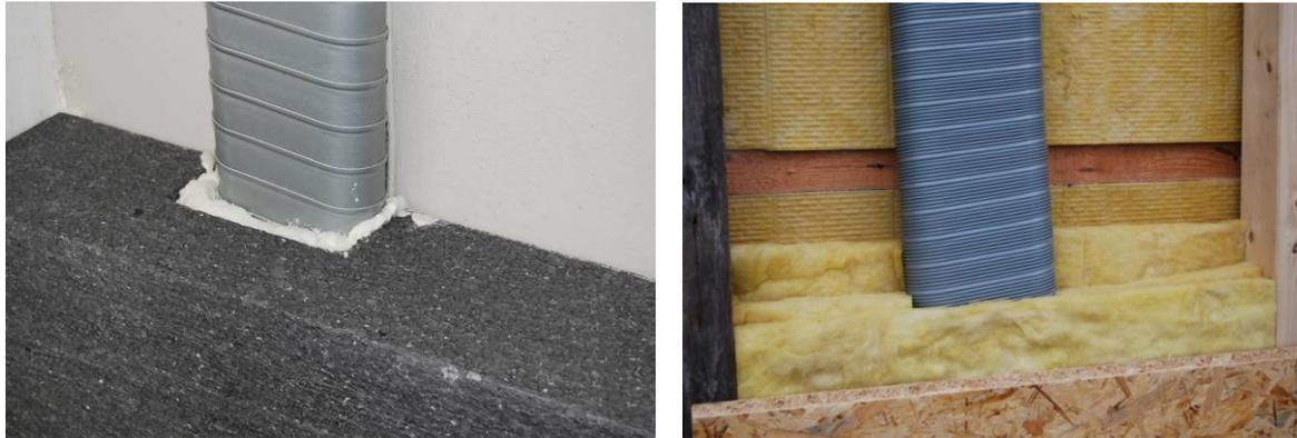
**Abbildung 4-38 Verlegung einer Lüftungsleitung außen auf der Fassade innerhalb des Wärmedämm-Verbundsystems und zwischen den Sparren eines Daches (Quelle: Ventecs)**
